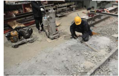
図 6 砂充填工法の施工状況
