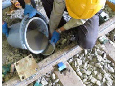
図 7 グラウト充填工法の施工状況
