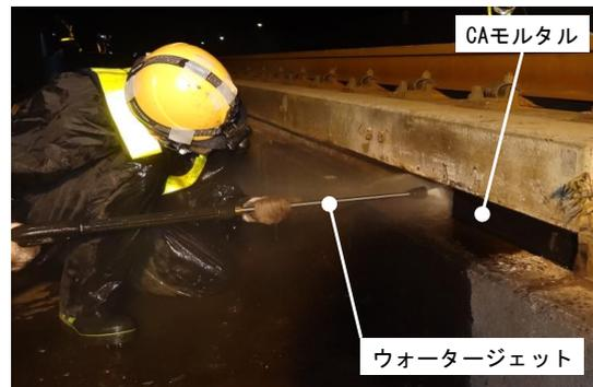
図 6 ウォータージェットによる CA モルタル除去
