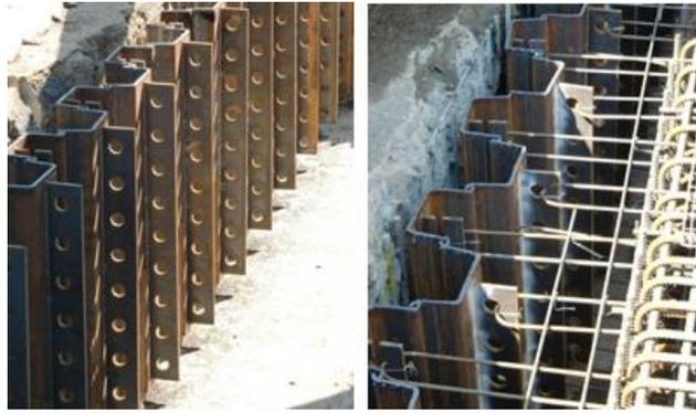
写真2 孔あき鋼板ジベルおよび施工例
