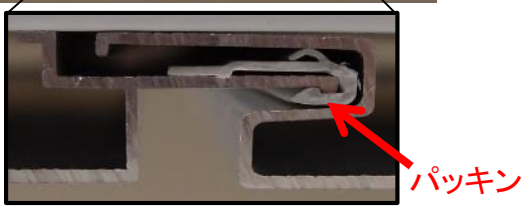
パッキンの設置状況
