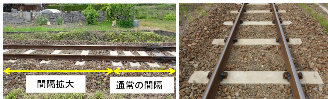
まくらぎ間隔拡大の実施状況
