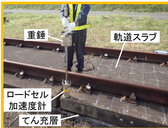
小型FWDによる隙間検出
