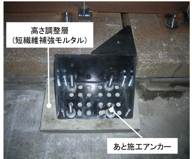
軌道スラブ水平変位拘束装置の設置状況の例
