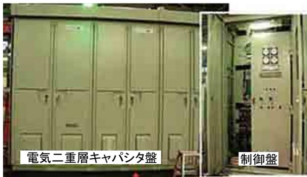
図3-1-10 電力貯蔵装置外観
