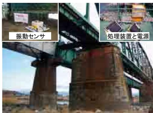
図3-1-16 橋脚基礎の健全性評価システムの現地測定橋脚と設置状況
