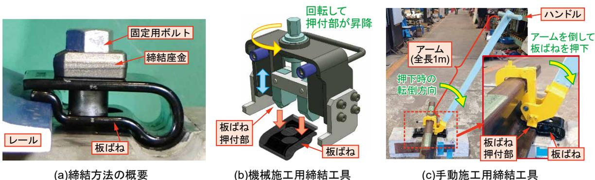
図2 レール締結方法と締結工具 (在来線・PCまくらぎ用の例)
