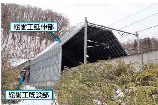
図3 新幹線トンネルに設置された断面積2段型緩衝工
