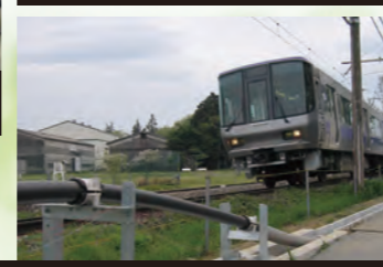
電気抵抗ゼロで送電できる「超電導送電ケーブル」 Superconducting feeder cable with no electrical resistance
