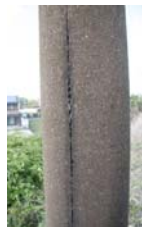
型枠継目 ひび割れ
