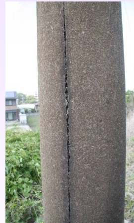
型枠継目 ひび割れ
