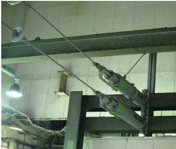
張力調整装置の例 (ばね式バランサ)
