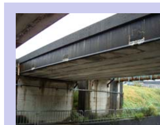
遠方からの目視調査
