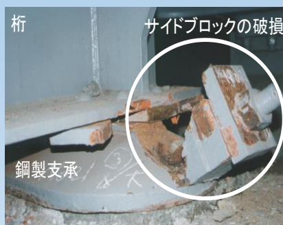
サイドブロックの破断
