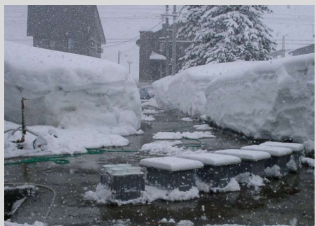
スプリンクラー散水試験
