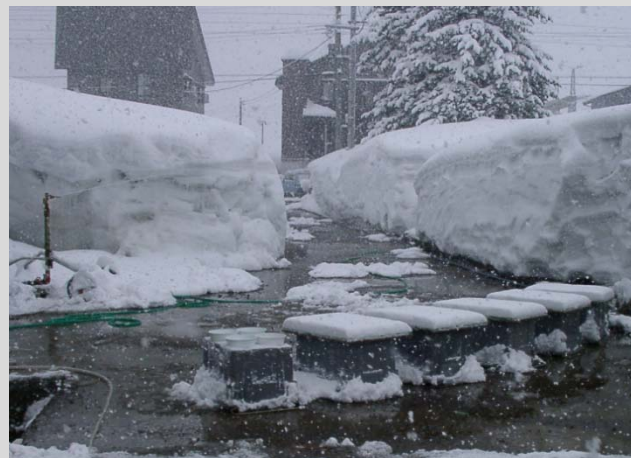
スプリンクラー散水試験
