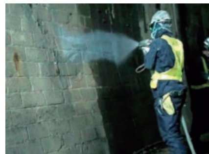
吹付けによる施工（イメージ）
