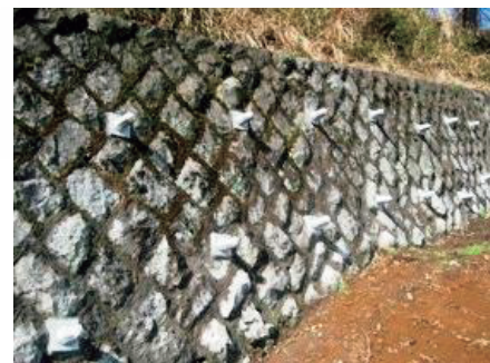
ピンナップ®工法の施工イメージ（左）と施工事例（右）
