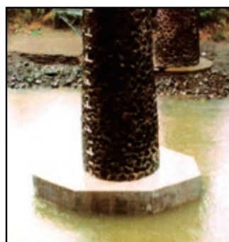
根固め工による復旧後
