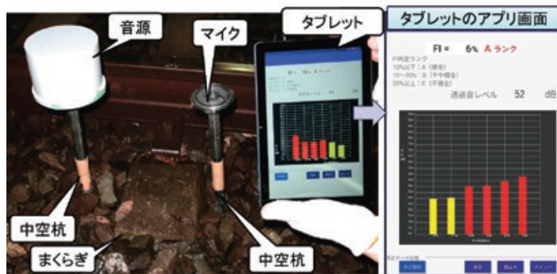
バラスト劣化状態検査装置による検査の様子
