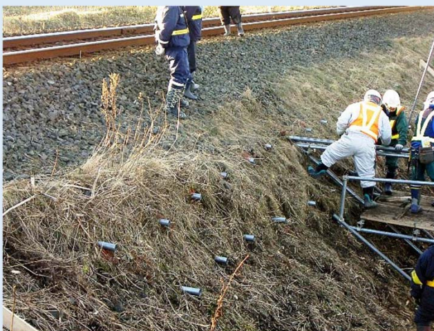
図1 排水パイプの打設状況の例
