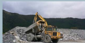
掘削残土を 盛土材として 利活用
