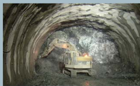
トンネル建設 工事等
