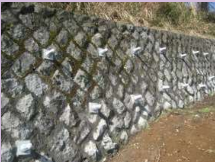
図2 ピンナップ®工法による補強事例
