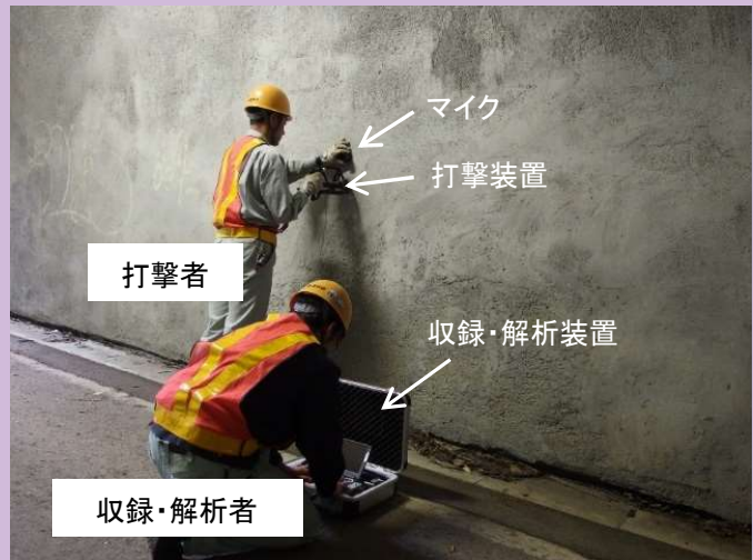
図2 トンネル覆工コンクリートの打音収録状況
