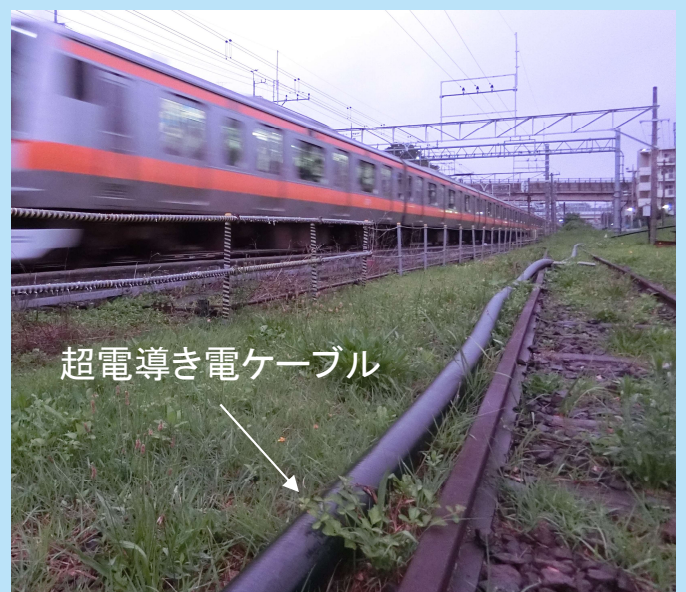
図4 超電導き電による列車走行
