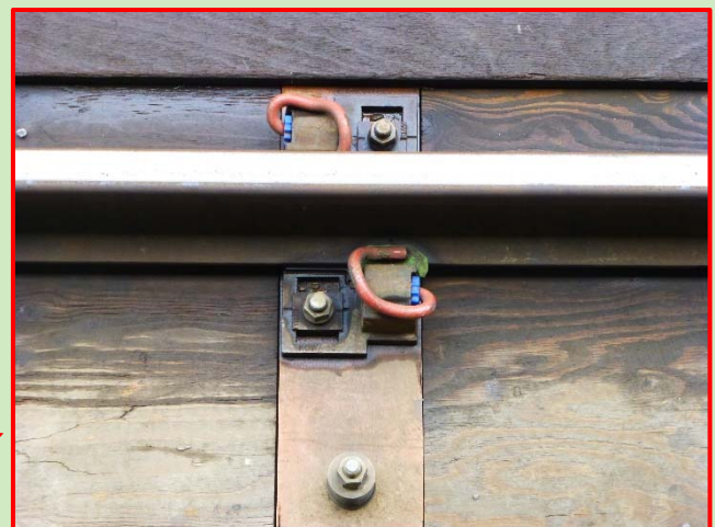
(レール締結装置の拡大図)
