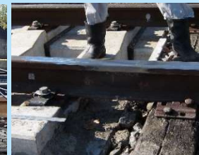
施工後の外観
