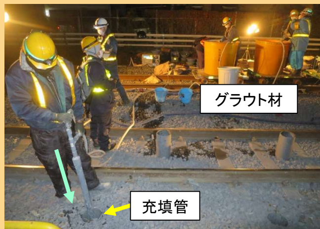
図2 グラウト材の充填状況
