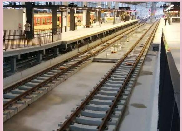
新たに開発したS型弾性まくらぎ直結軌道の構造
