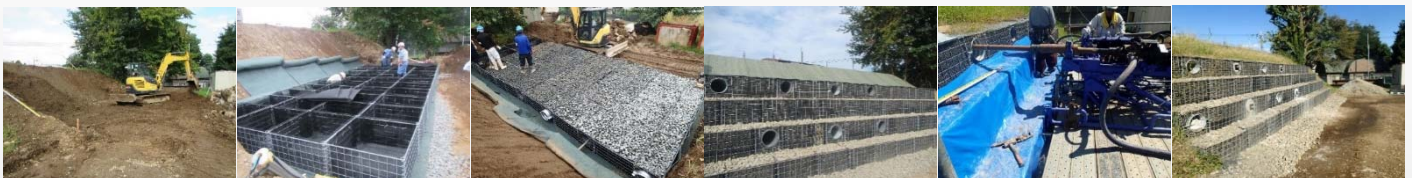
①整地・段切り ②かご枠組立て ③中詰め・転圧 ④断面確保 (列車運行可能) ⑤地山補強土工 ⑥完成
