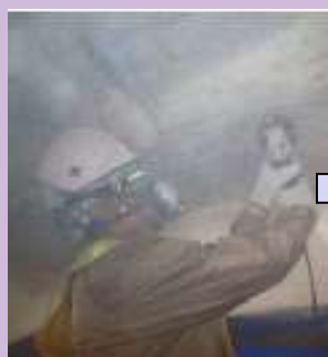
①下地処理工
