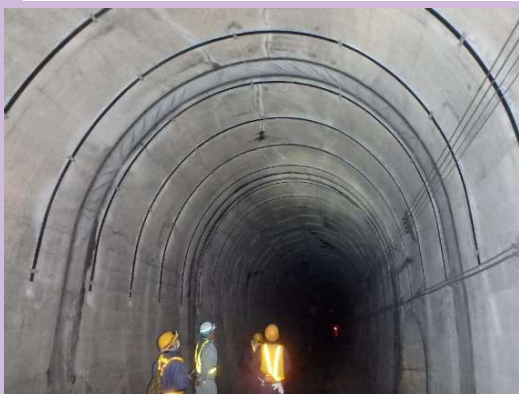
無筋コンクリート覆工での施工例
