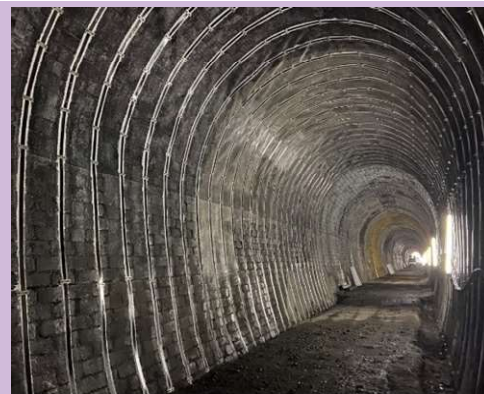
ブロック積み覆工での施工例
