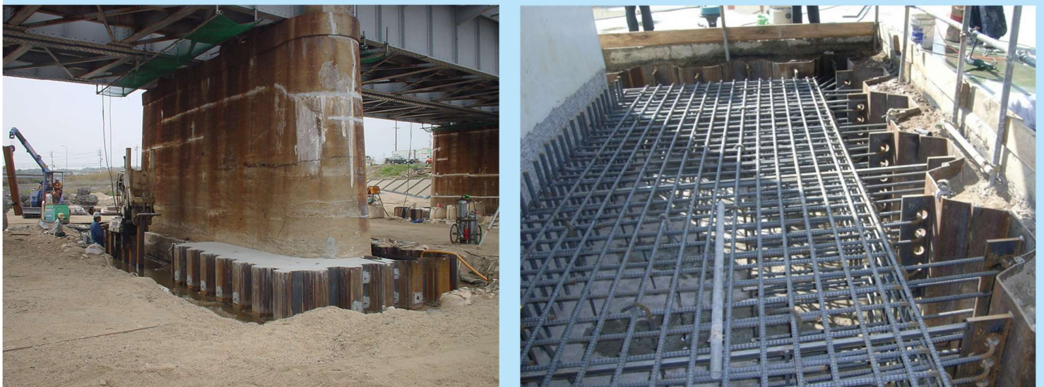
図2 シートパイル補強の例
