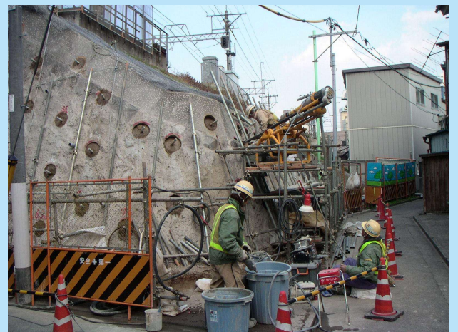
図4 既設土留め壁の補強
