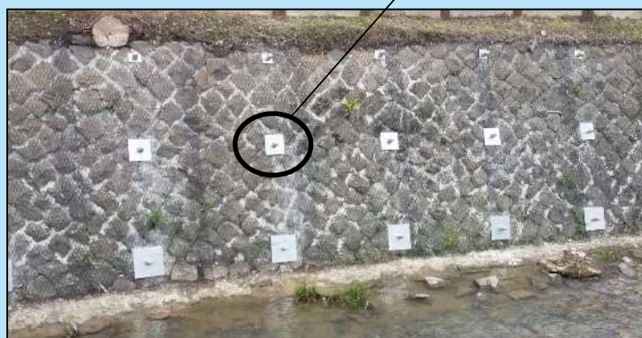
図2 耐震補強法の施工事例
