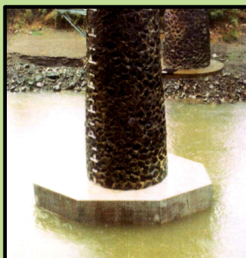
根固め工による復旧後
