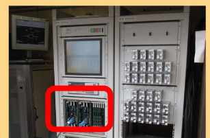
図3 駅制御装置 (枠内が論理部)
