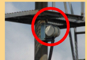
図2 無線アンテナ (信号機柱に仮設した状態)
