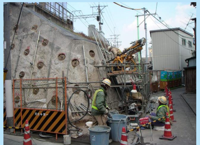
図4 既設土留め壁の補強
