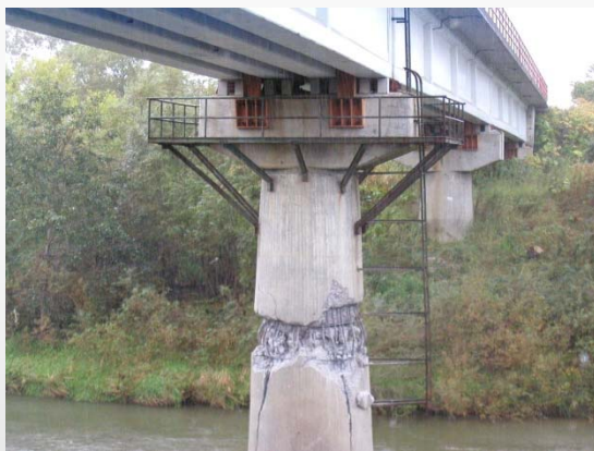
段落しを有する鉄筋コンクリート橋脚の破壊事例
