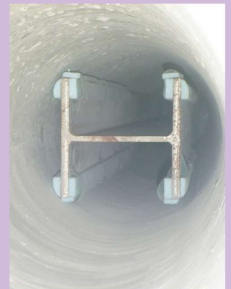
図2 芯材としてH鋼を挿入した例(ウレタンでPC電化柱と心材を一体化)
