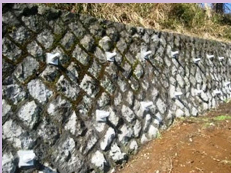
図2 ピンナップ®工法による補強事例
