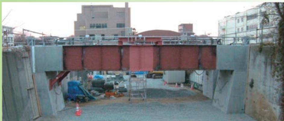
既設盛土一体化橋梁の実大試験橋梁による検証
