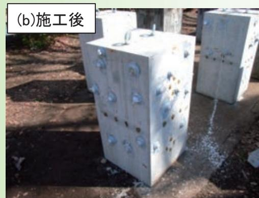
コンクリート表面の0.2mm以上のひび割れからゴムの復元力を使用して低圧注入します。
