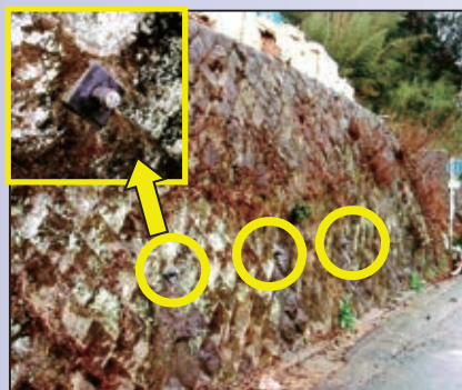
施工後の壁面の状態 石積みの景観を残したまま 補強が可能です
