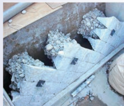
壁背後の固化体の状況 部分的な固化により裏グリ石層の 排水機能を維持します
