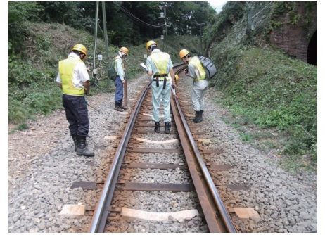
現地調査の様子
