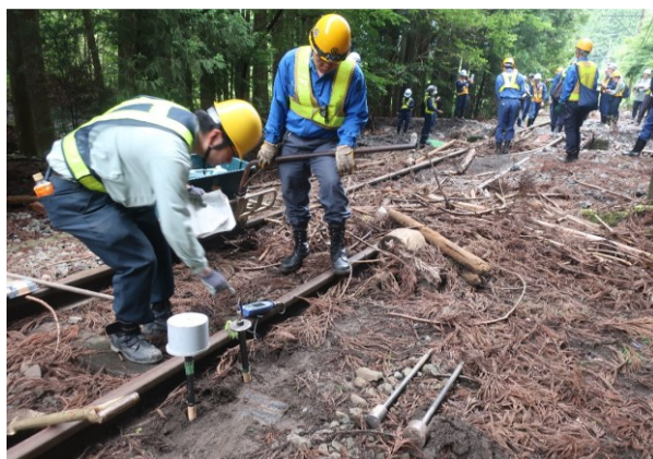
簡易な機器による軌道設備の調査（台風被災関連）
