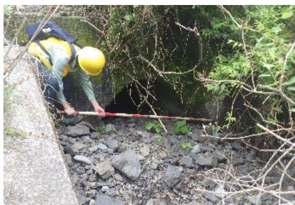
暗渠の土砂流入箇所の目視（台風被災関連）
